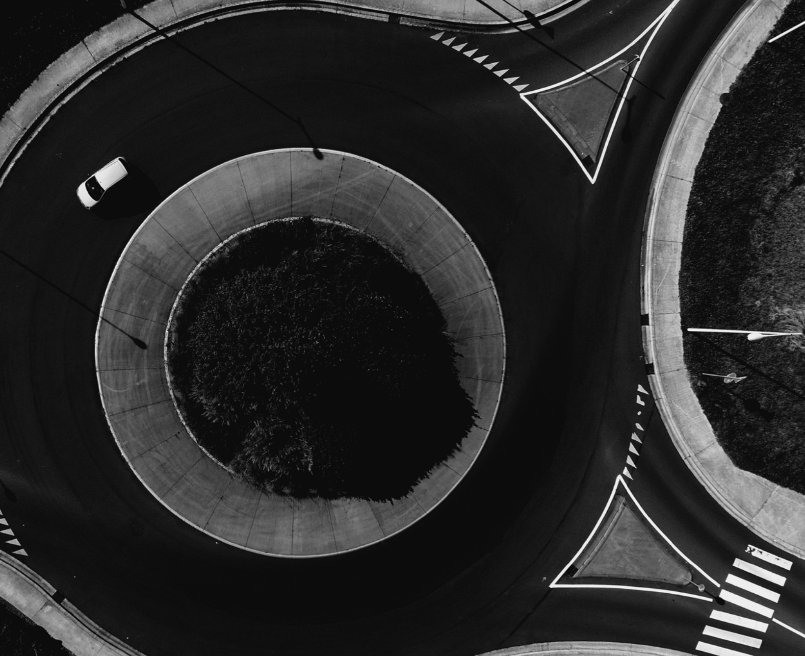
Slaggasfalt är särskilt lämplig för utsatta ytor, som exempelvis cirkulationsplatser, korsningar och busshållplatser. FOTO: Pexels
